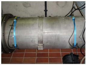
Druckrohrmessung mit Clamp-On
